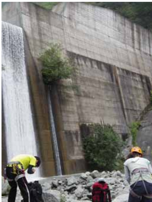
林道終点に立つ大堰堤
